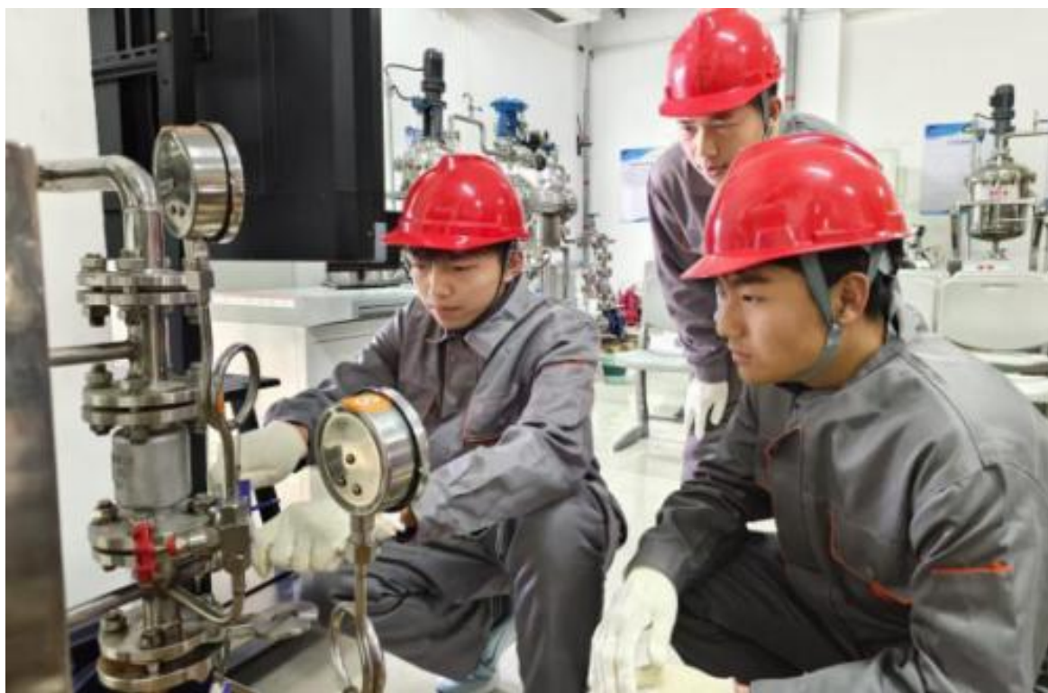
图5-8 东营职业学院学生在石油化工技术实训基地进行储罐输送管线检修操作
